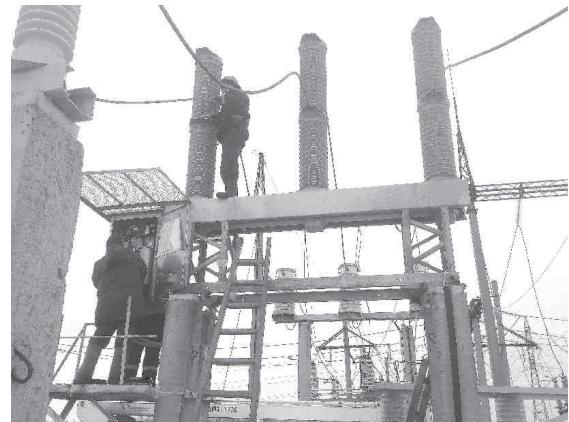
шает возможности масляных выключателей ВМТ), минимальные расходы по эксплуатации (ВРС-110 нужно лишь изредка смазывать и осматривать), длительный срок работы (вакуумный выключатель ВРС-110 рассчитан на 25-летнее использование).
