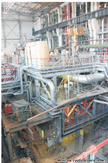
Монтаж турбоагрегата №1
