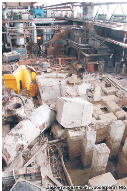
Демонтированный турбоагрегат №5
