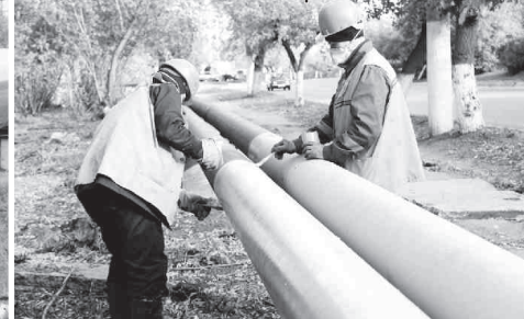
ТМ № 11 после капитального ремонта
