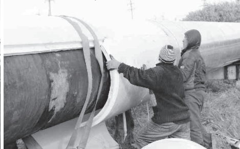
Монтаж ППУ-изоляции на ТМ № 1
