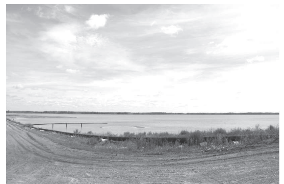
Золоотвал № 2 Петропавловской ТЭЦ-2 АО «СЕВКАЗЭНЕРГО»
