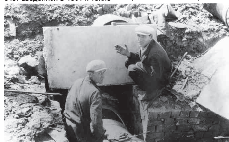
Трудовые будни слесарей по ремонту тепловых сетей, 1972 год
