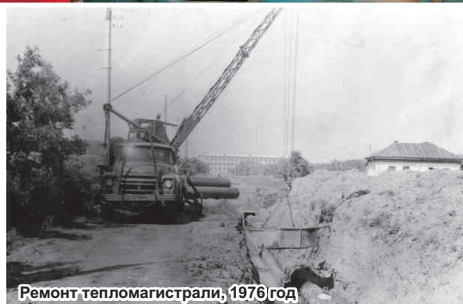
Ремонт тепломагистрали, 1976 год
