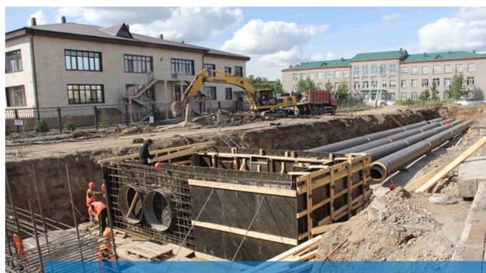
Август 2017 г., реконструкция ТМ № 1 по ул. Алтынсарина
